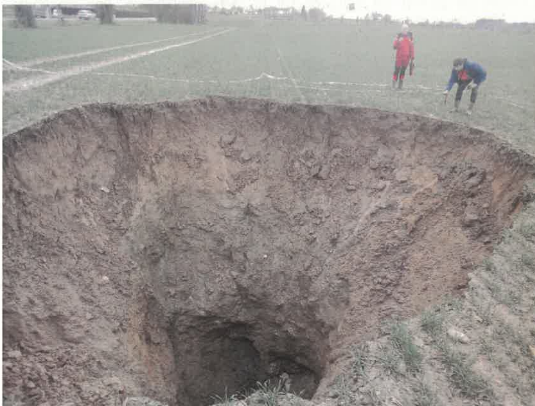
Figure 13 –L'effondrement de la Malaunière, BRGM 05/02/2021
